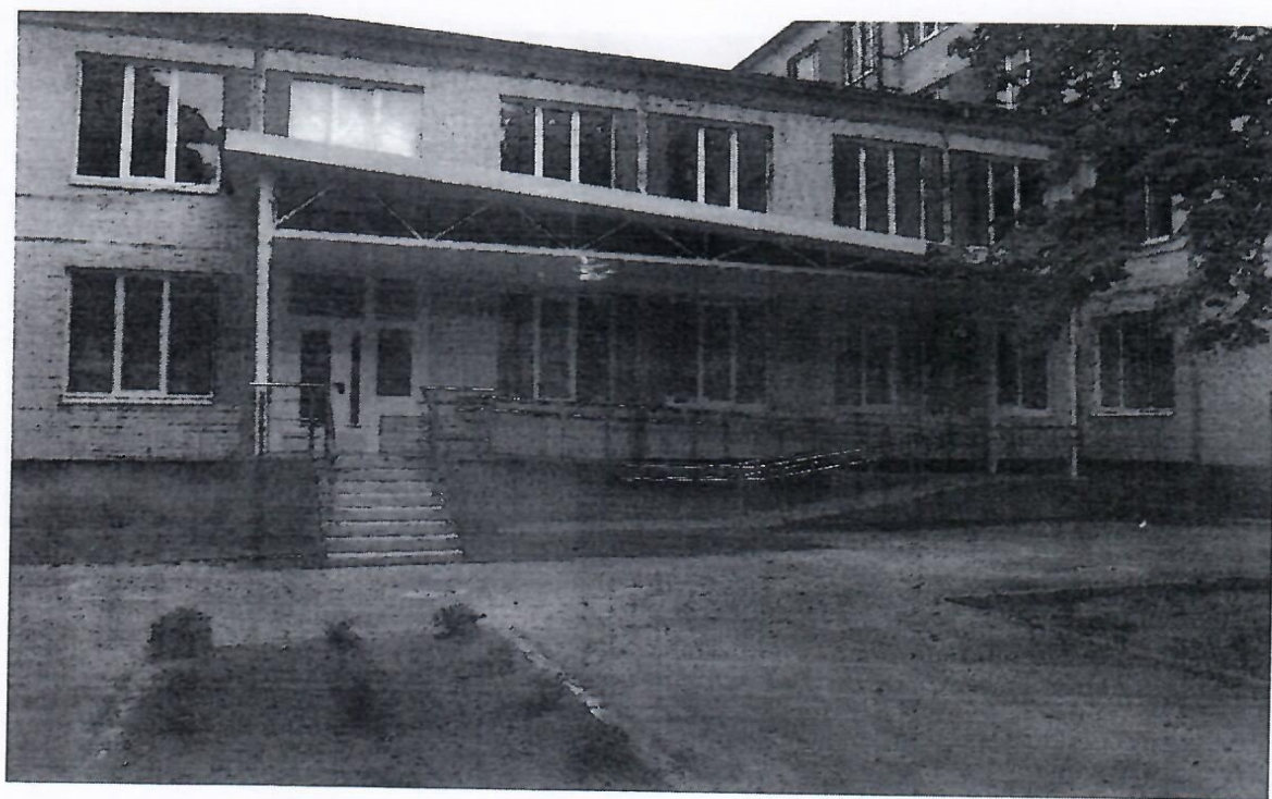
МБОУ «Кингисеппская СОШ №4» Оборудованный вход в здание для лиц с ограниченными возможностями (ПАНДУС) рис. № 2
